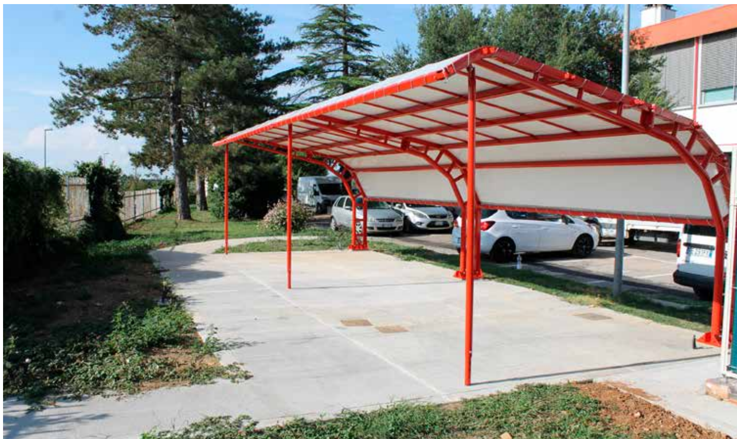
Pensilina Ibis, profondità 3,8m, passo 5m, composta da 2 moduli, con piloncino di emergenza abbassato. Trattamento superficiale di zincatura a caldo e verniciatura colore rosso.
