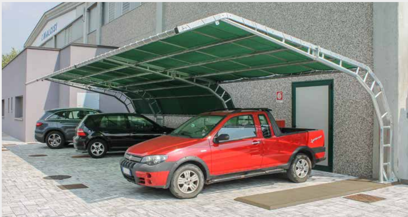
Pergolato Ibis con copertura in rete ombreggiante e zavorramento con piastroni in acciaio.
